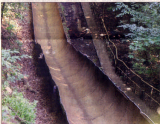
In der halbierten alten Wasserleitung schlittern die abgetrennten Rohrstücken zu Tale. In einer Woche soll vom Eisen nichts mehr übrig sein.
