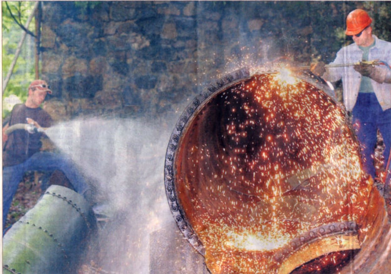
Abriß mit Feuer und Wasser im Tharandter Badetal: Während die alte Eisenröhre unter Peter Eichlers Schneidbrenner zerfällt, ist ein Kollege mit dem Schlauch auf Posten. Der Brandschutz hat im Wald oberste Priorität. Fotos: Holm Helis (2)
